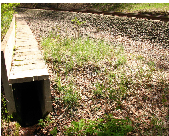
Prefabrikovaný žlab na protější straně tratě
