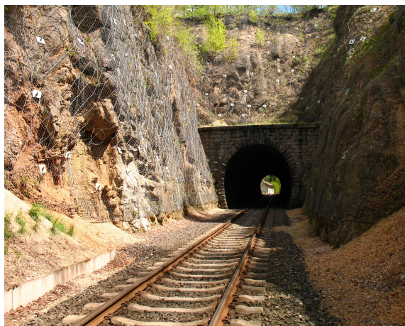
Obr. 6 Vjezdový portál se skalním zářezem
