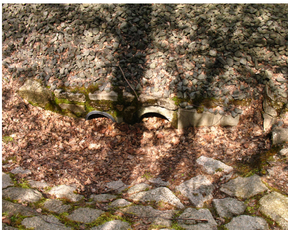
Pohled na ústí dvou trub pod šterkovým ložem
