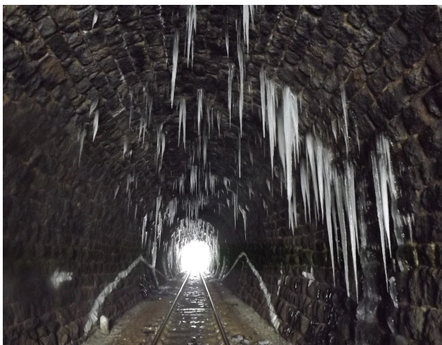
Obr. 8 Průsaky - tvorba rampouchů a otevřené trhliny v obezdívce
