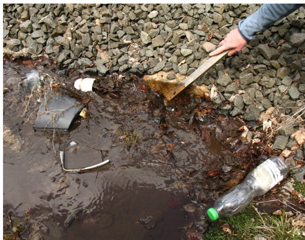
Zanesený vtok propustku
