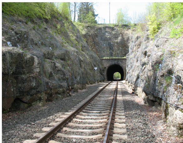
Obr. 7 Výjezdový portál se skalním zářezem
