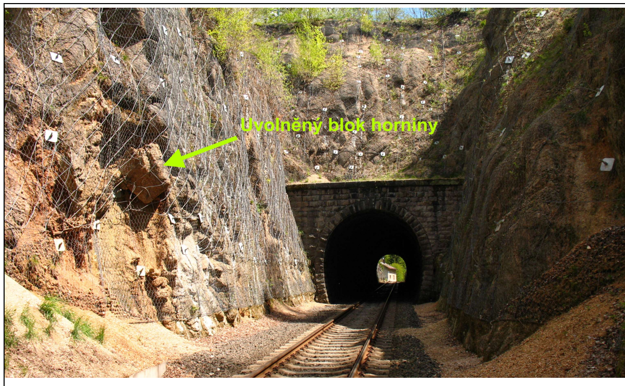
Obr. 1 Zajištění skalních zářezů a uvolněný blok horniny
